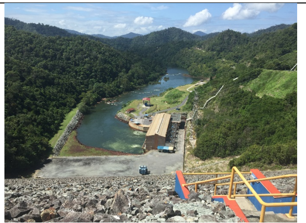
Temengor Dam, Tenaga Nasional Berhad (TNB)
